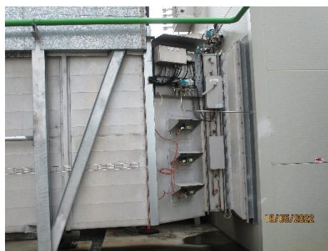
ภาพที่ 2.2-27 ระบบป้องกันการรั่วซึมของก๊าซ (Gas Detector บริเวณ Gas Turbine)
