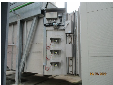
ภาพที่ 2.2-27 ระบบป้องกันการรั่วซึมของก๊าซ (Gas Detector บริเวณ Gas Turbine)
