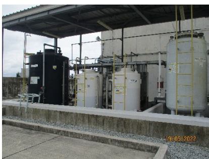
ภาพที่ 2.2-35 คันคอนกรีตรอบถังเก็บ
