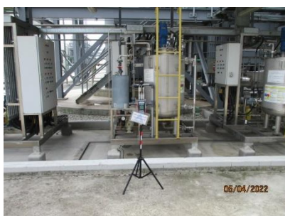
Chemical Dosing HRSG
