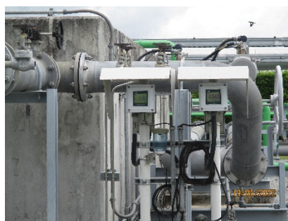
ภาพที่ 2.2-13 ระบบติดตามตรวจสอบคุณภาพน้ำแบบต่อเนื่อง
